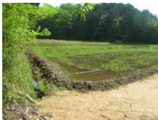
完成した湿地8・9
