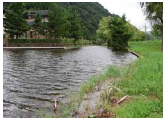
新設された汽水水路(延長:140m)
