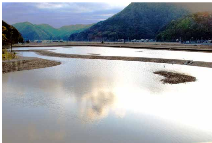
完成した戸島湿地全景
