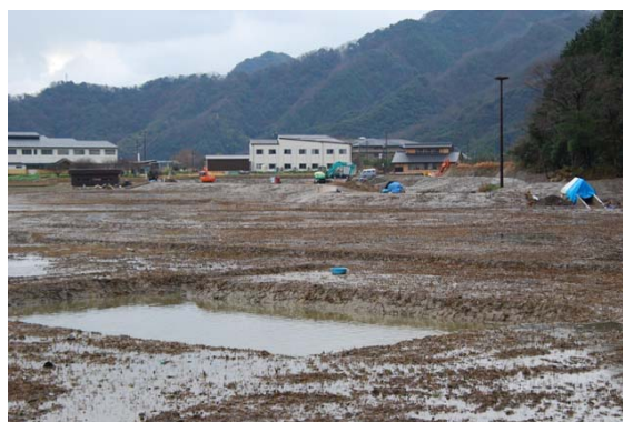
▲2008年12月18日戸島湿地工事中
